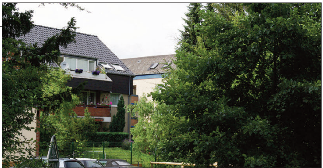
Waren 2009 Stein des Anstoßes, die Dächer der beiden Häuser, Alt-Rudow 53.
