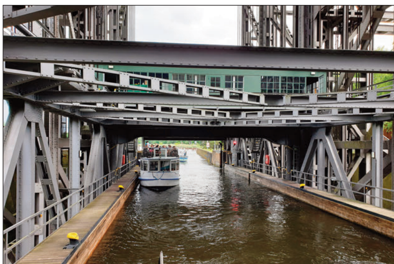
Einfahrt mit dem Schiff in den Trog des alten Schiffshebewerkes
