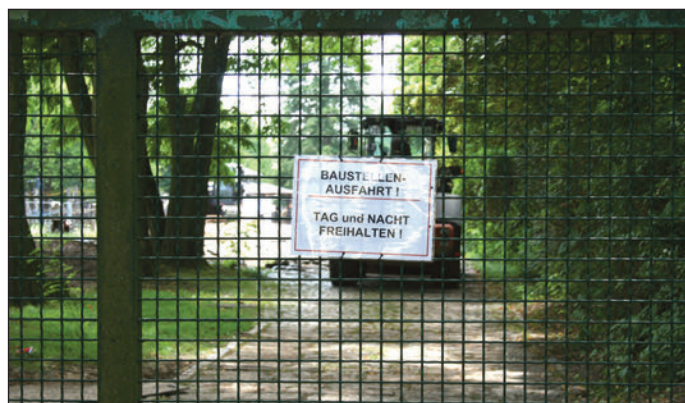
Die ersten Bagger sind schon angerückt, um mit dem Umbau der Spiellandschaft im Britzer Garten zu beginnen.
