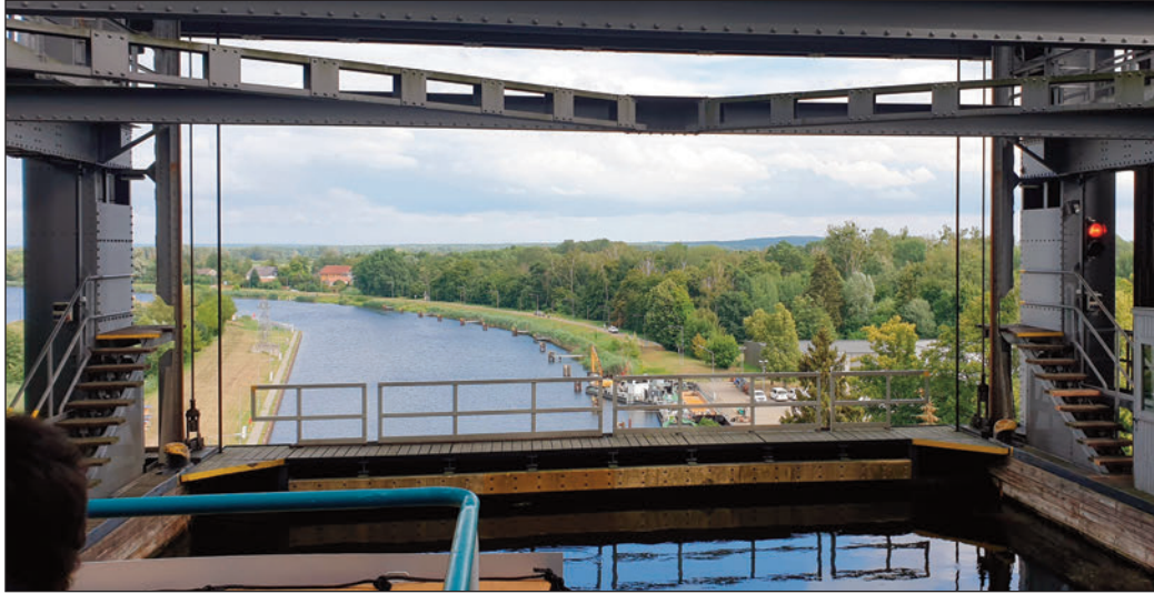
Ausblick aus 36 Meter Höhe nach der Hebung des Troges.
