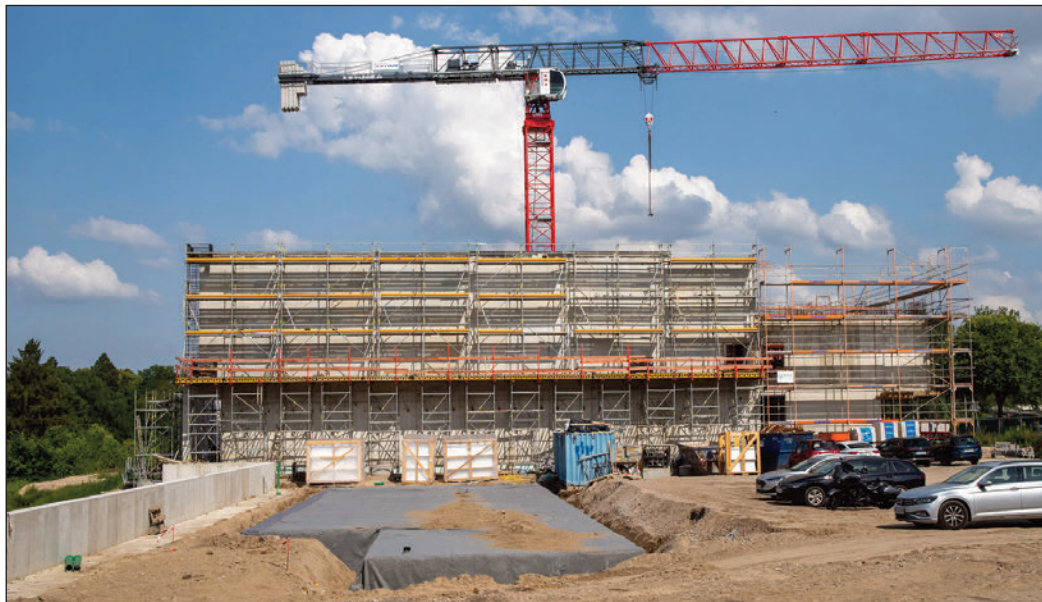
432 neue Grundschulplätze entstehen hier. Die Turnhalle kann auch von Vereinen genutzt werden. Fotos: S.P.
